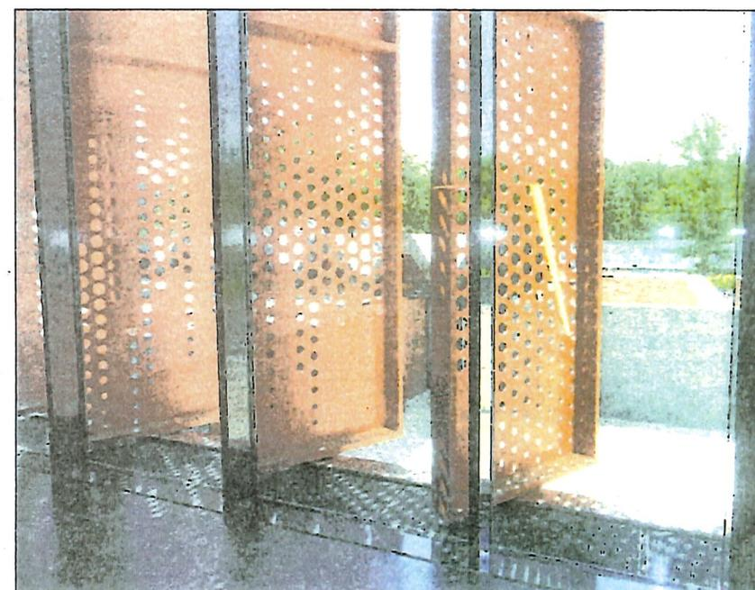
Die Lamellenfenster, die nach einem Prototyp gefertigt wurden, schließen oder öffnen sich je nach Sonnenstand. Foto: flz
